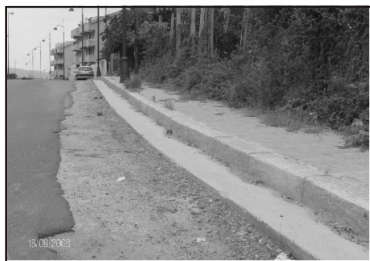
ASFALTO "FINITO" E MARCIAPIEDI ERBOSI
